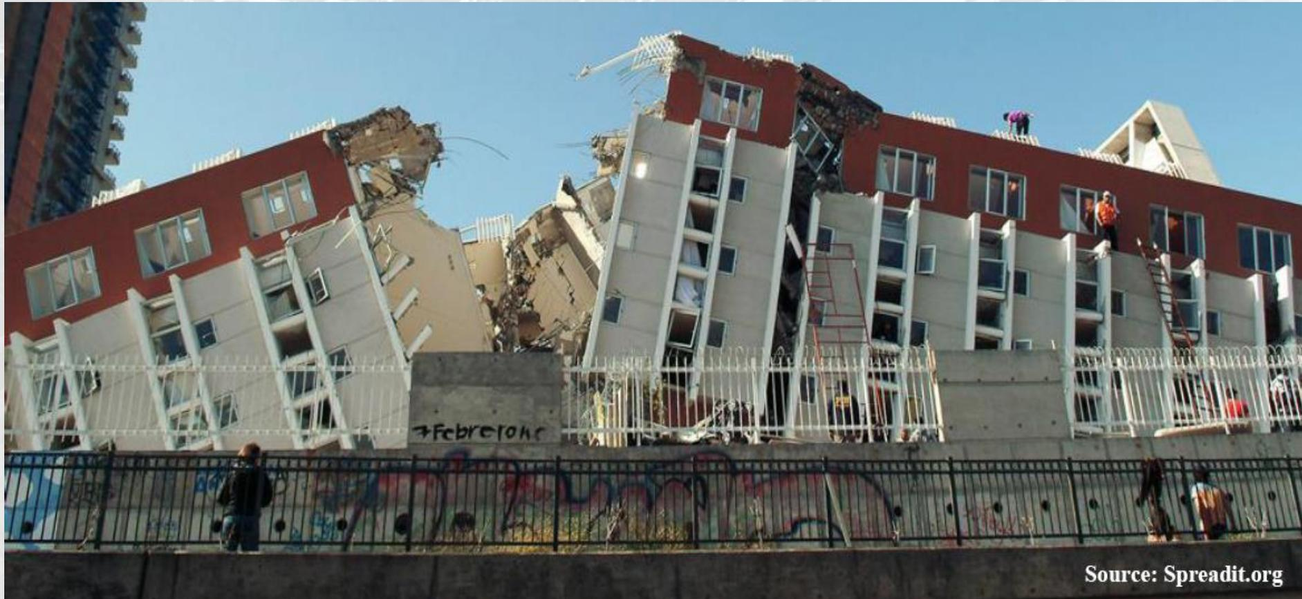
**Colapso Edificio de Hormigón Armado – Falla Geológica
