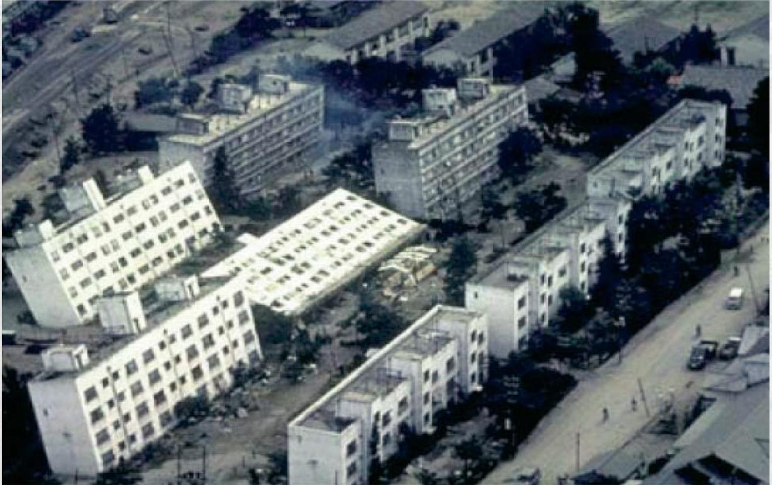
**Falla Edificio de Hormigón Armado – Licuación de Suelos
